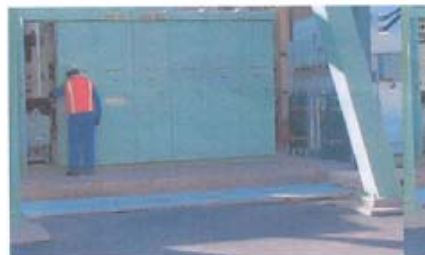
Χειρισμός του διακόπτη με το αριστερό χέρι. Ο χειριστής στέκεται πλευρικά
